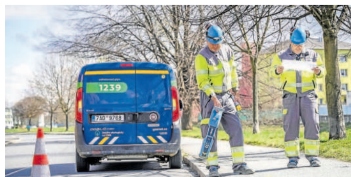
SLUŽBA VYTYČENÍ SÍTĚ JE ZDARMA. Foto: GasNet
